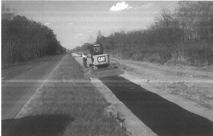
Épülő kerékpárút Kisvarsány és Vásárosnamény között (Forrás: beregihirek.hu)
